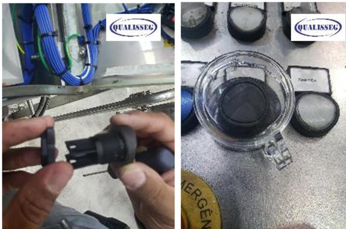
1. Solicite a um Eletricista autorizado e qualificado que retire a botoeira de acionamento ou chave seletora ou botoeira emergência, desmontando o bloco inferior no painel. O procedimento é simples e o bloqueio fica permanentemente instalado no painel.
